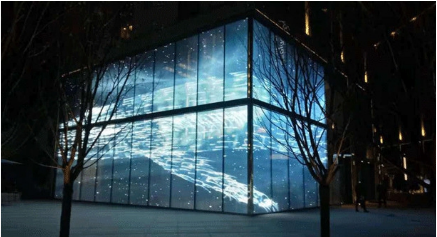
杭州良渚未来之光项目
